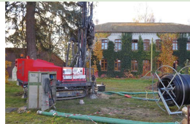
Die Fläche vor dem Haus bietet ausreichend Platz für sechs Erdbohrungen.
